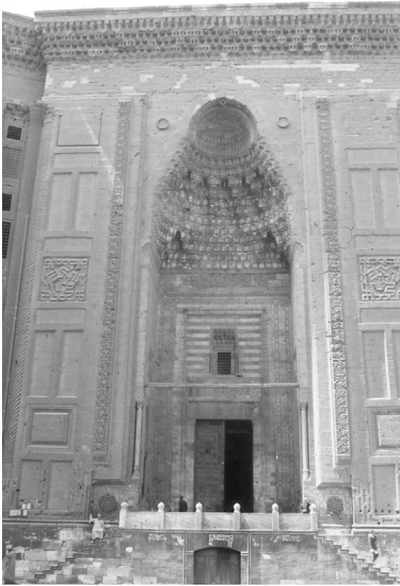
La mosquée du Sultan Hassan, 1356-1363
